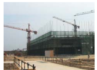
Baustelle während Errichtung der Fabrik
