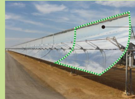
再生可能エネルギーの一つとして注目される集光型太陽熱発電は、多数の鏡で反射・集中した太陽光を熱源とする発電システムです。コニカミノルタは、培ってきた高度な材料技術を駆使して、高い反射性能と優れた耐久性を持つ「フィルムミラー」を開発。今後は事業化を加速し、太陽熱発電の普及と発展に貢献していきます。
