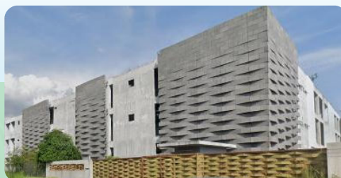
クアラルンプール新工場
