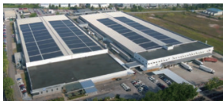
生産拠点の敷地内に太陽光発電システム(設置面積17,059平方メートル、発電容量3.4MW)を導入
