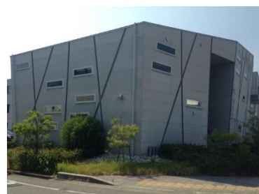
「KONANDO Lab」 外観
