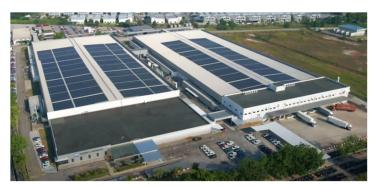
BMMYは、2023年3月より太陽光発電システム(設置面積17,059平方メートル、発電容量3.4MW)を導入<sup>\*1</sup>し、電気使用量の約20%<sup>\*2</sup>を太陽光発電で賄うこととなり、すでに導入済みの再工ネ電力証書<sup>\*3</sup>付きの電力と合わせて、再工ネ100%<sup>\*4</sup>を達成しました。
