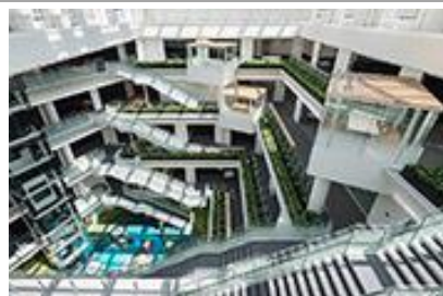
SKT のアトリウム（吹き抜け）
