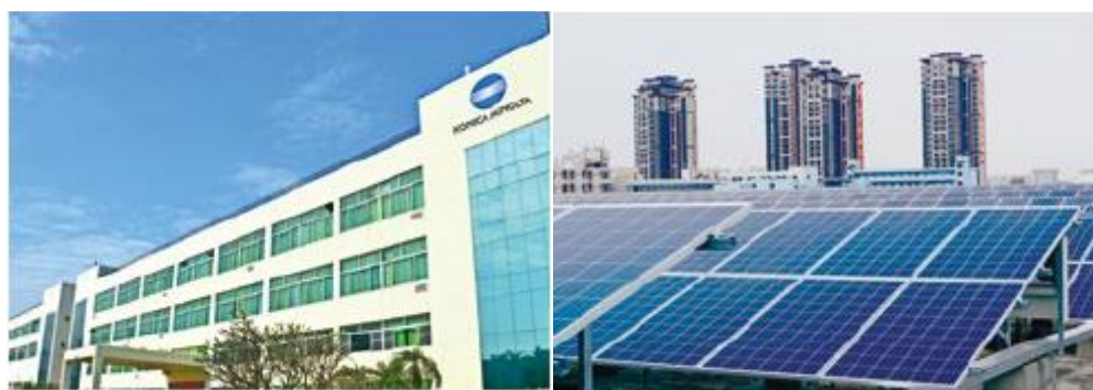
コニカミノルタビジネステクノロジーズ（東莞）社 工場屋根に取り付けられた太陽光発電パネル群
