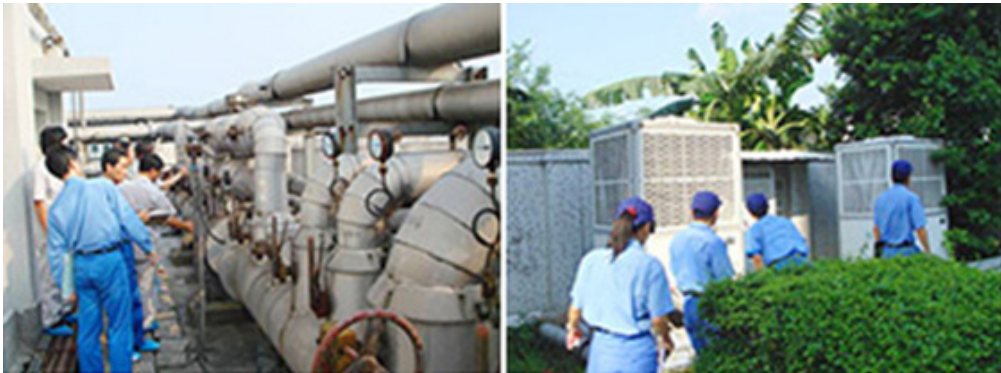
現場巡視によるエネルギー使用状況の診断
