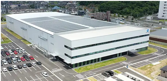
コニカミノルタメカトロニクス社の豊川市本社と、屋根に積載した太陽光発電パネル
