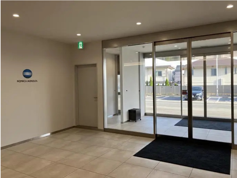
自動ドアの停電時に備え設置された非常出口
